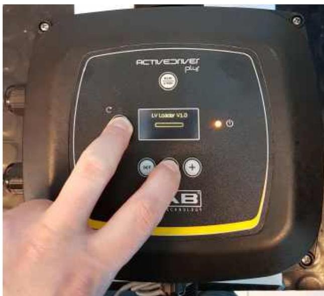
Рисунок 9В - Обновление Active Driver Plus ПО 1.X
